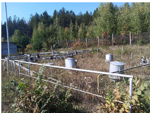
Емкости для СУГ 4,2 м3 и емкости для СУГ 2,5 м3
