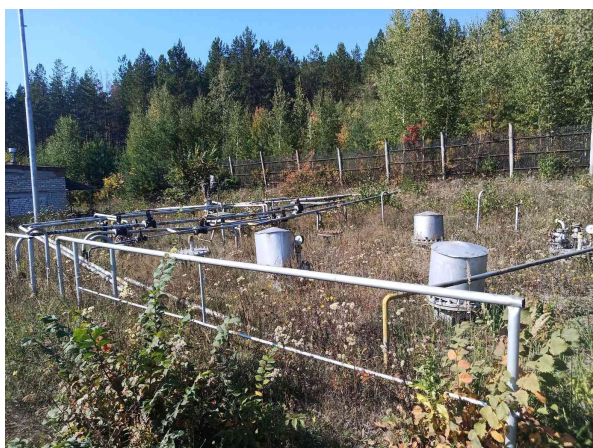
Емкости для СУГ 4,2 м3 и емкости для СУГ 2,5 м3
