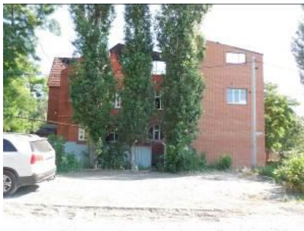
Земельный участок и внешний вид здания
