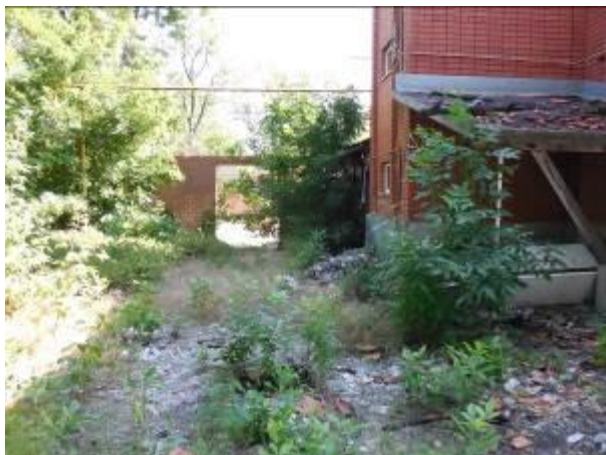
Земельный участок и внешний вид здания
