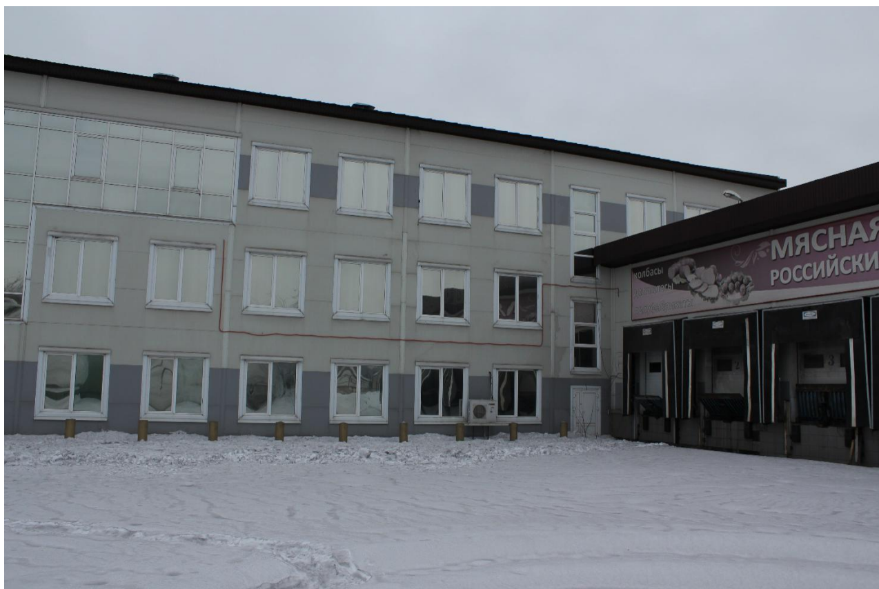
Здание административно-бытового корпуса
