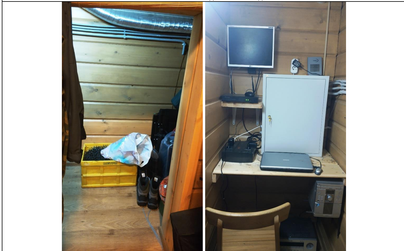
Фото 66. Состояние отделки жилого дома
