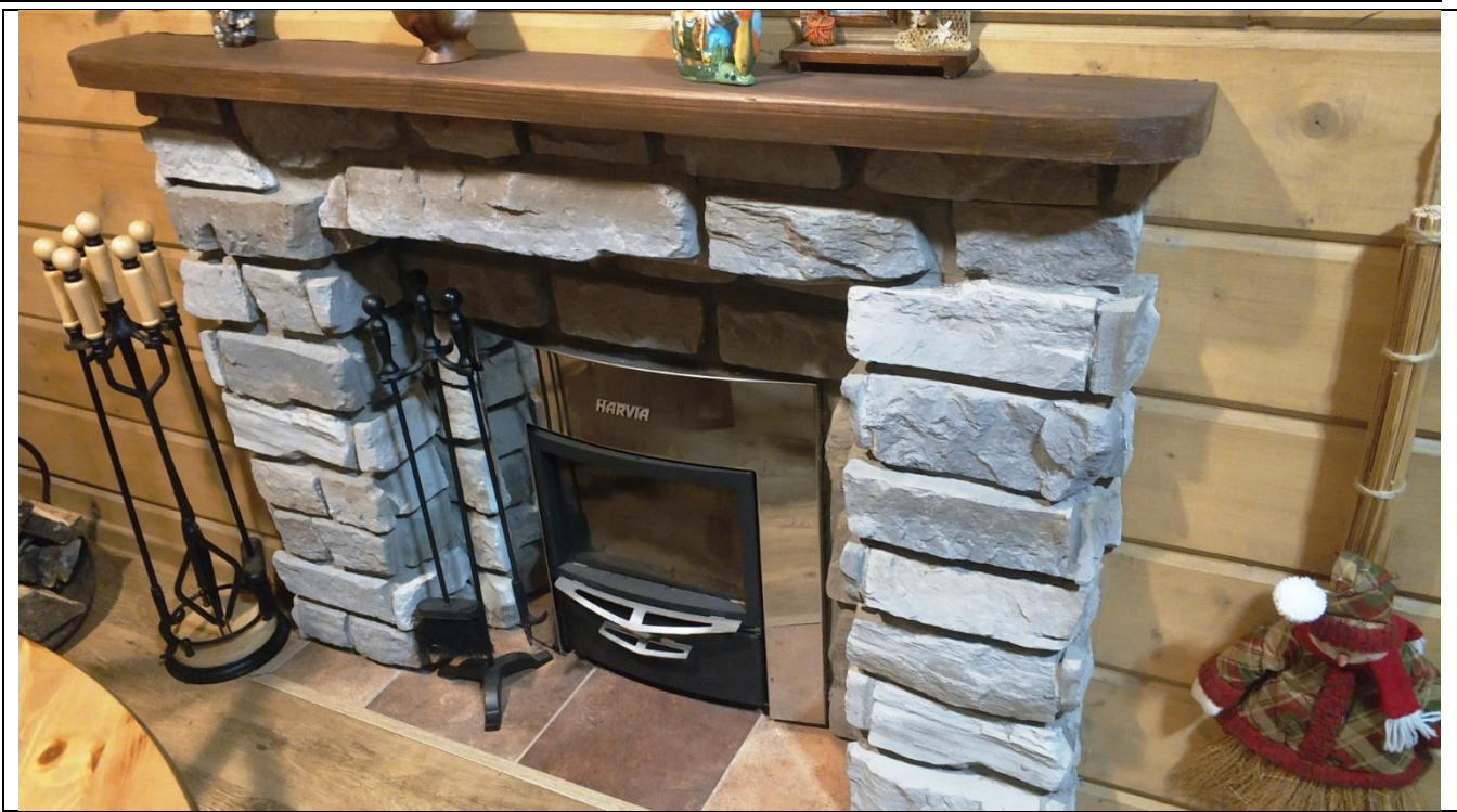
Фото 25. Состояние отделки гостевого дома
