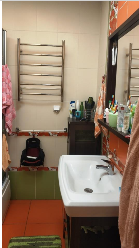
Фото 51. Состояние отделки жилого дома
