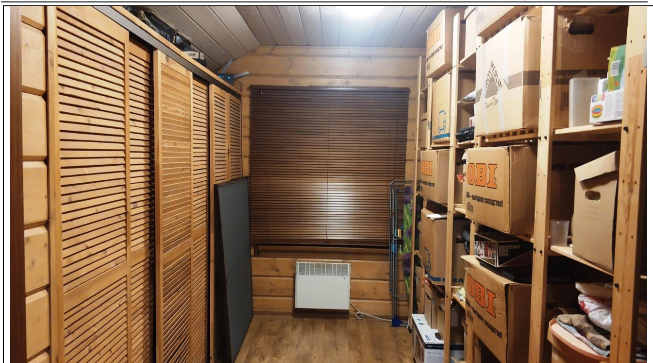
Фото 65. Состояние отделки жилого дома
