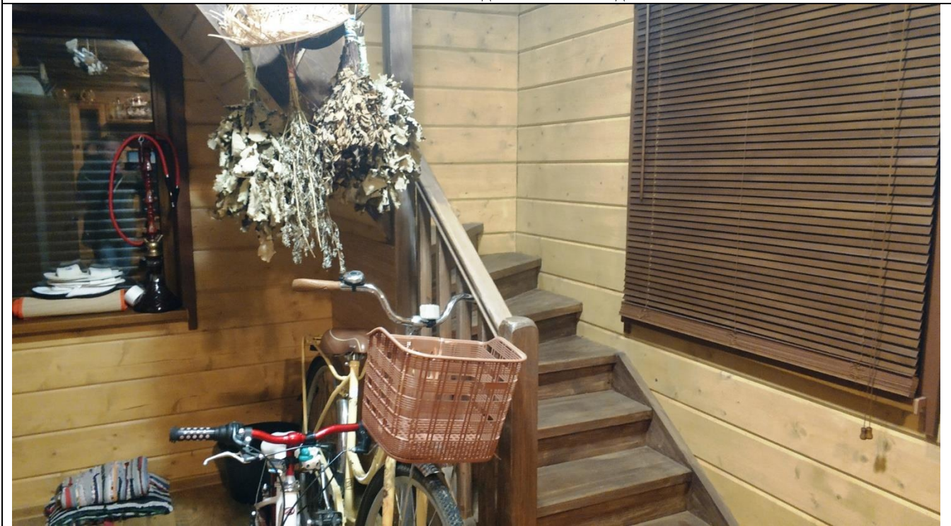
Фото 26. Состояние отделки гостевого дома
