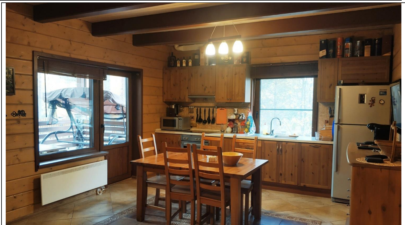
Фото 43. Состояние отделки жилого дома
