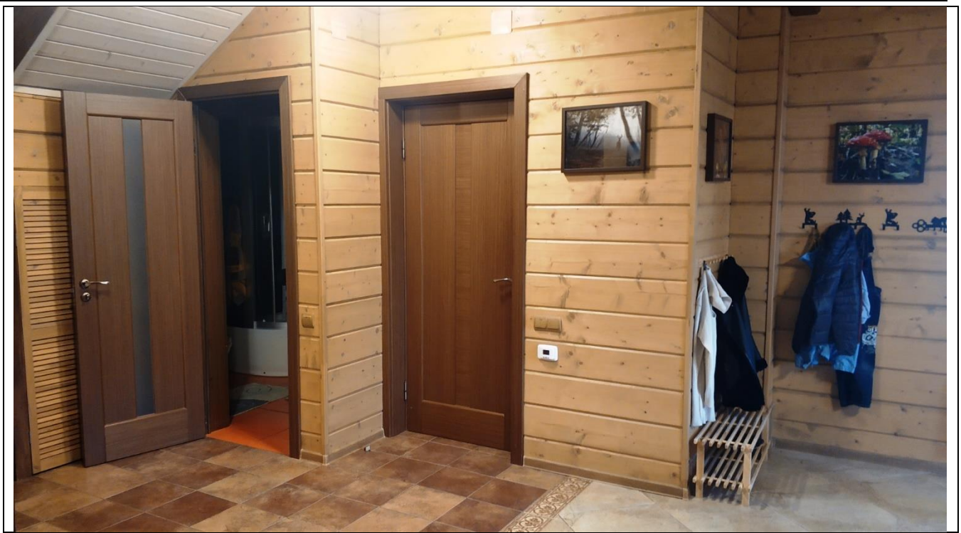
Фото 49. Состояние отделки жилого дома
