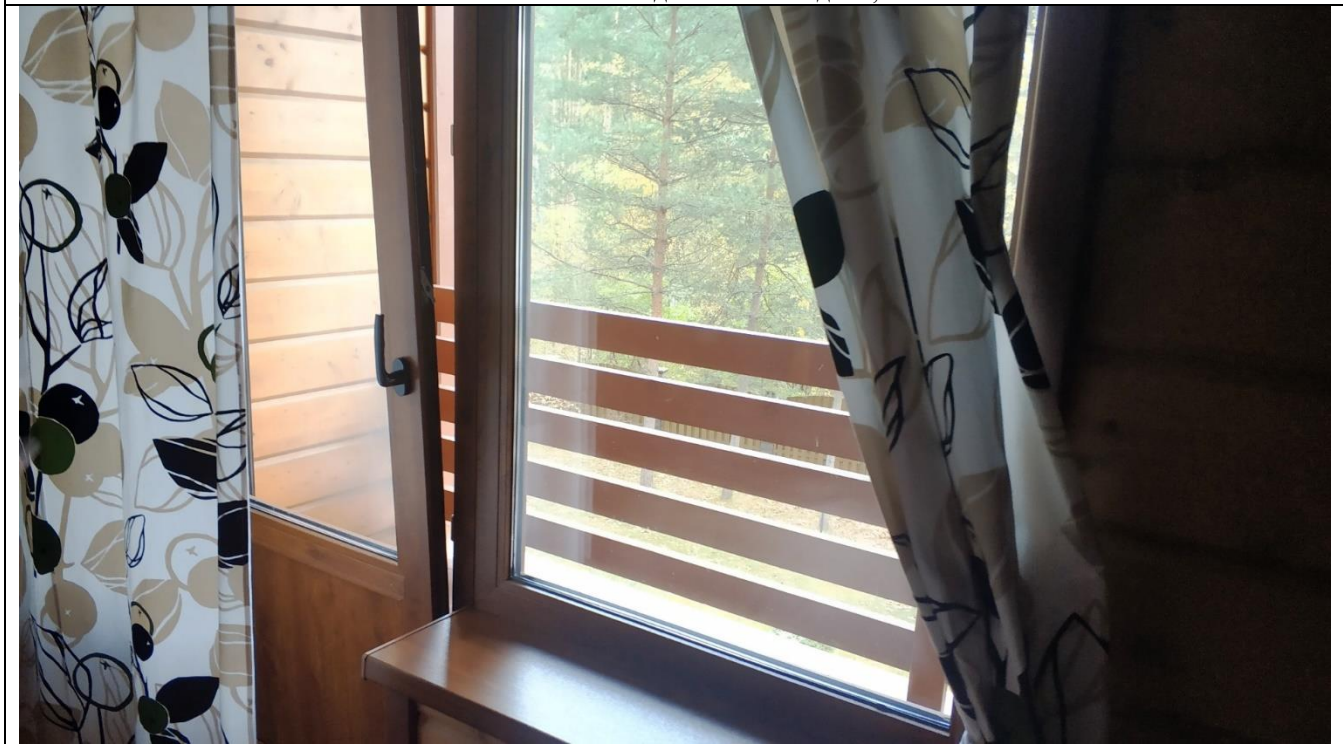
Фото 72. Состояние отделки жилого дома
