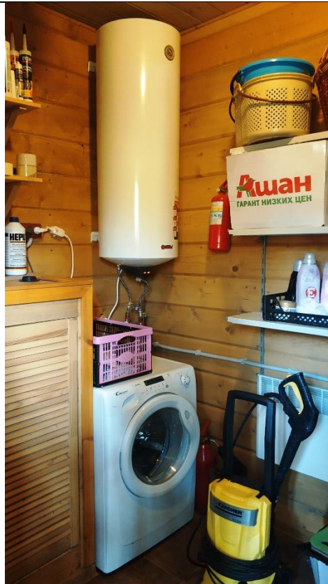
Фото 41. Состояние отделки жилого дома
