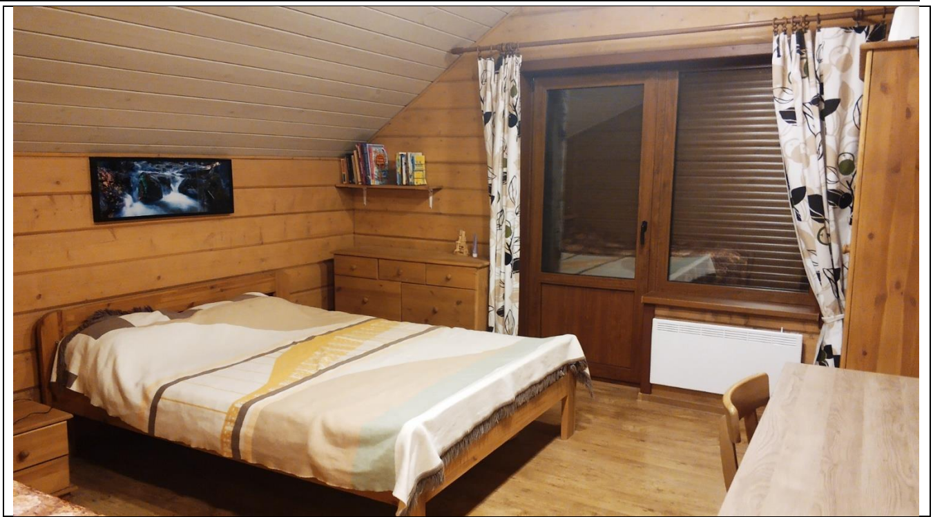
Фото 61. Состояние отделки жилого дома
