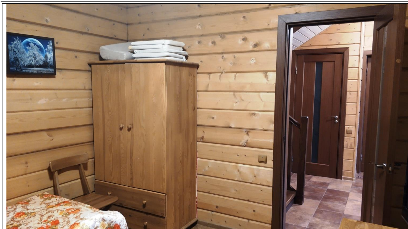
Фото 55. Состояние отделки жилого дома
