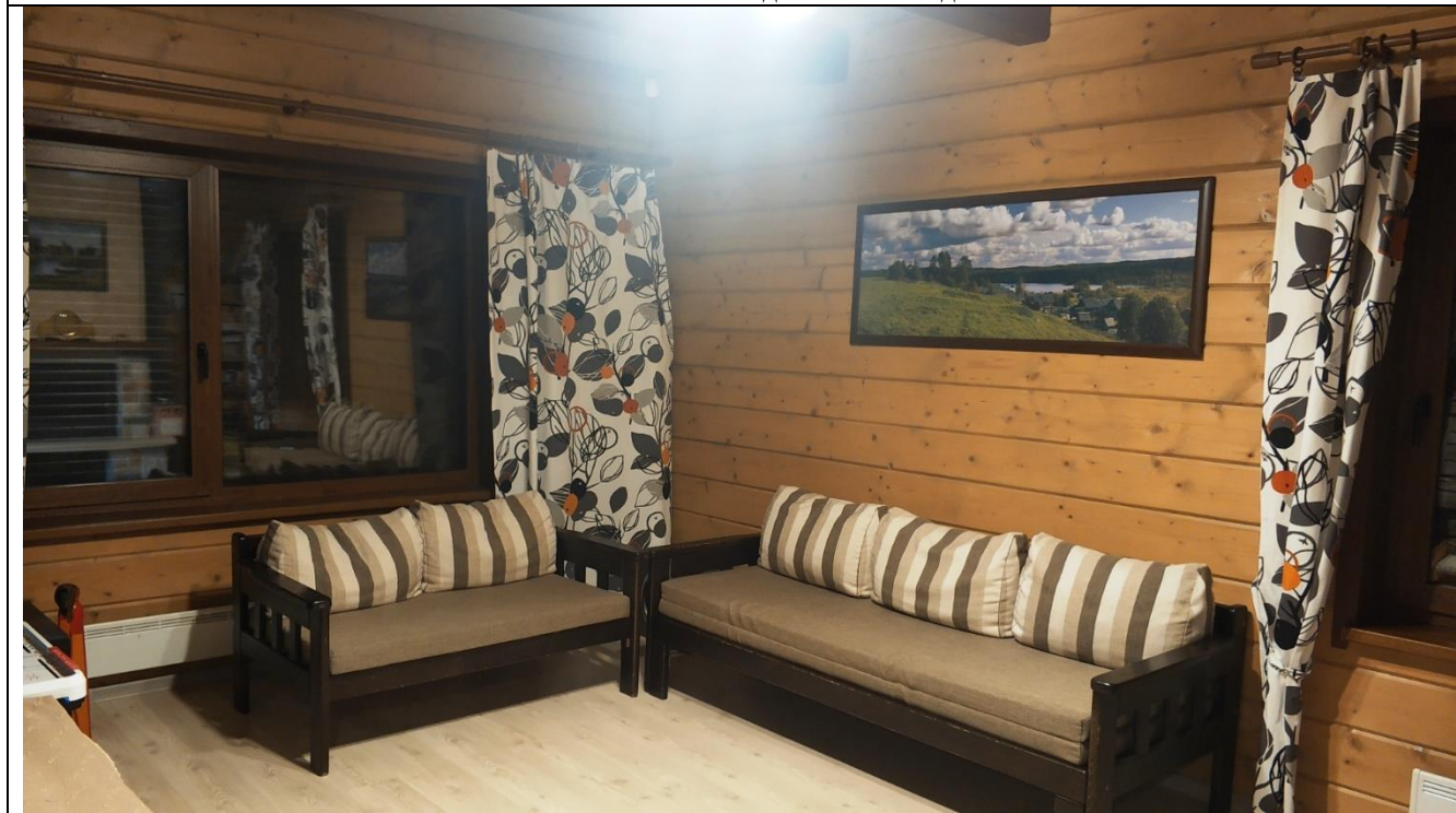
Фото 46. Состояние отделки жилого дома
