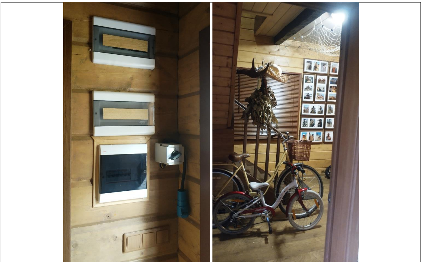
Фото 23. Состояние отделки гостевого дома
