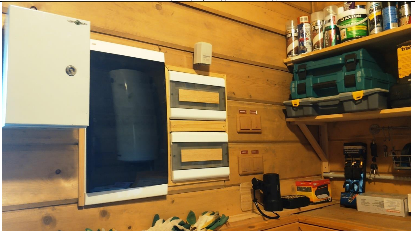
Фото 38. Состояние отделки жилого дома
