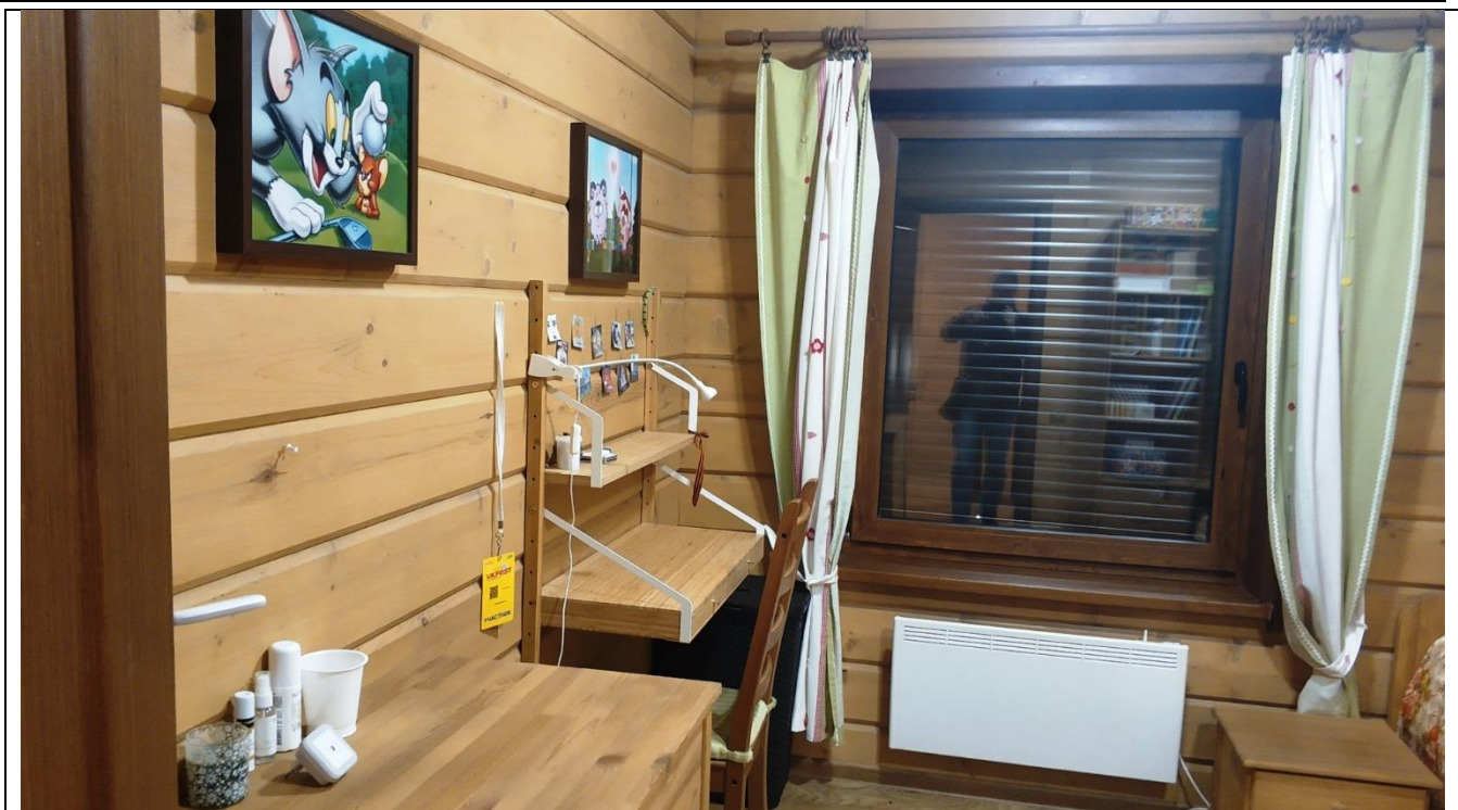
Фото 79. Состояние отделки жилого дома
