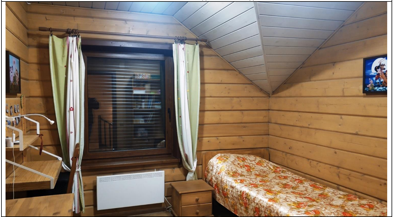
Фото 78. Состояние отделки жилого дома
