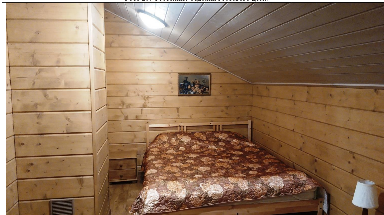
Фото 30. Состояние отделки гостевого дома
