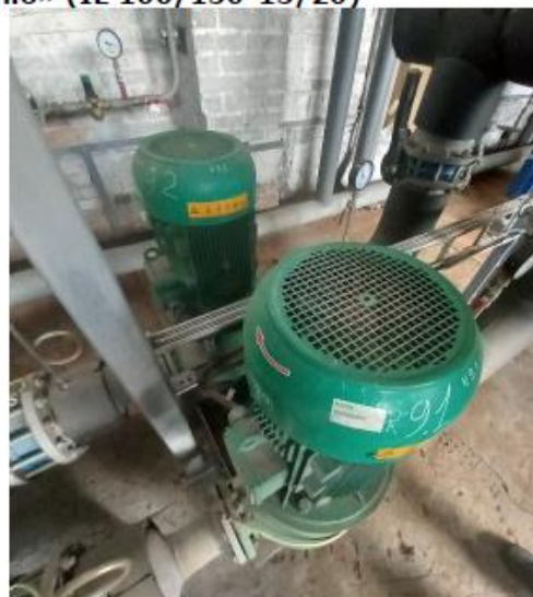
Насос сетевой циркуляционный «Wilo» (IL 100/150-15/20)
