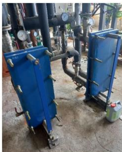
Пластинчатый теплообменник (SR 2-12)
