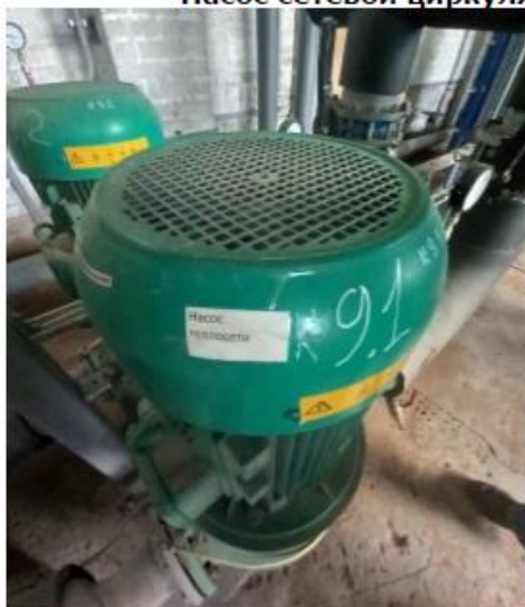
Насос сетевой циркуляционный «Wilo» (IL 100/150-15/20)
