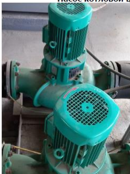
Насос сетевой циркуляционный «Wilo» (IL 100/150-15/20)
