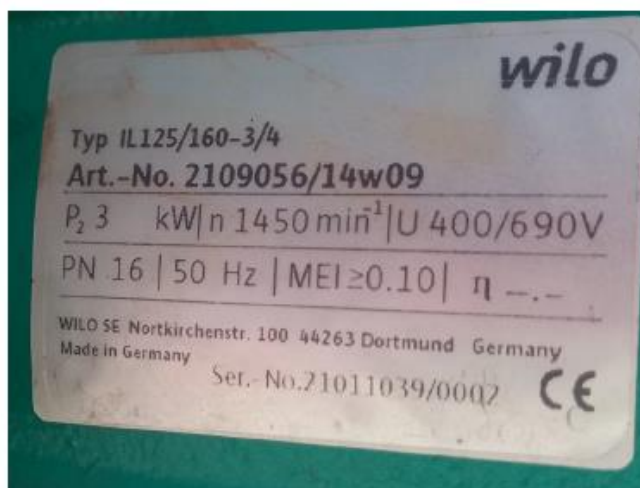
Насос котловой циркуляционный «Wilo» (IL 125/160 -3/4)
