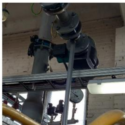
Насос подмешивающий котловой «Wilo» (TOP-S 65/10 DN65/PN10)
