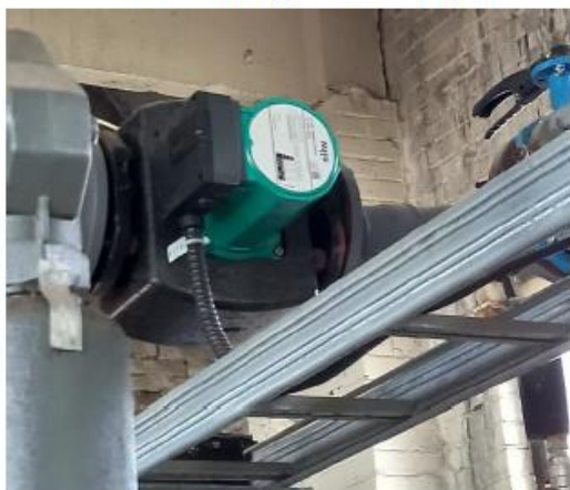
Насос подмешивающий котловой «Wilo» (TOP-S 65/10 DN65/PN10)
