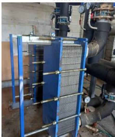
Пластинчатый теплообменник (O 034 EnergySaver)
