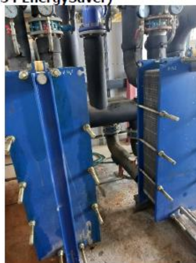
Пластинчатый теплообменник (O 034 EnergySaver)
