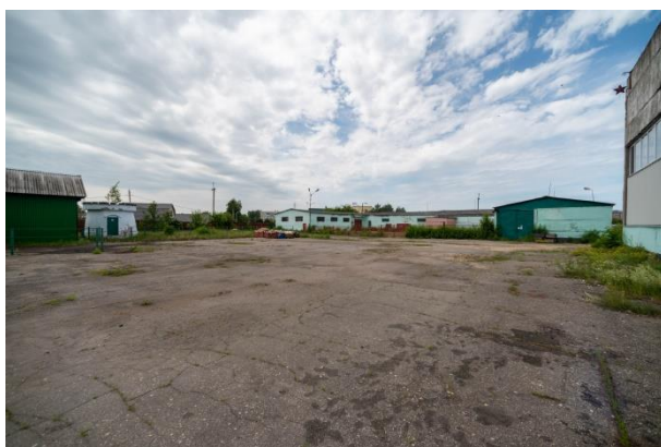
Фото 7.5. Сооружение площадка козлового крана, назначение: площадка общей площадью 2 838 кв. м, кадастровый номер 62:27:0000000:197
