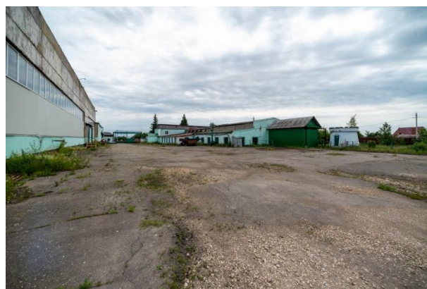
Фото 7.6. Сооружение площадка козлового крана, назначение: площадка общей площадью 2 838 кв. м, кадастровый номер 62:27:0000000:197
