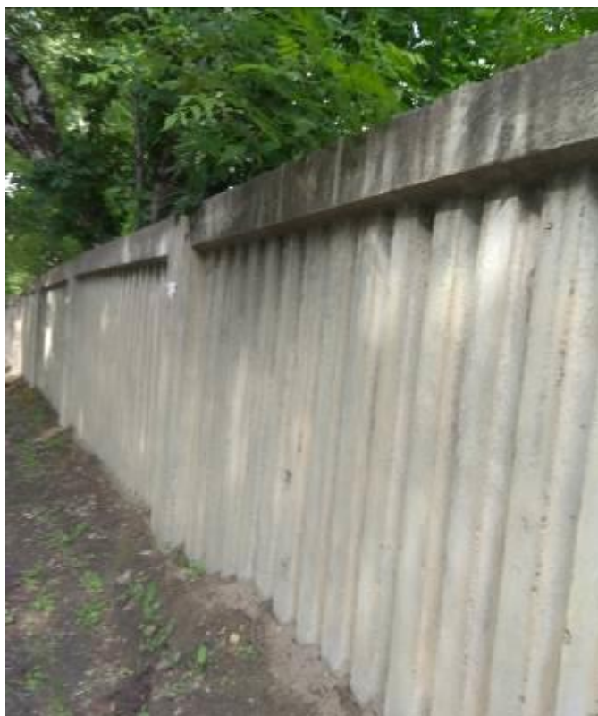
Железобетонный забор по периметру территории
