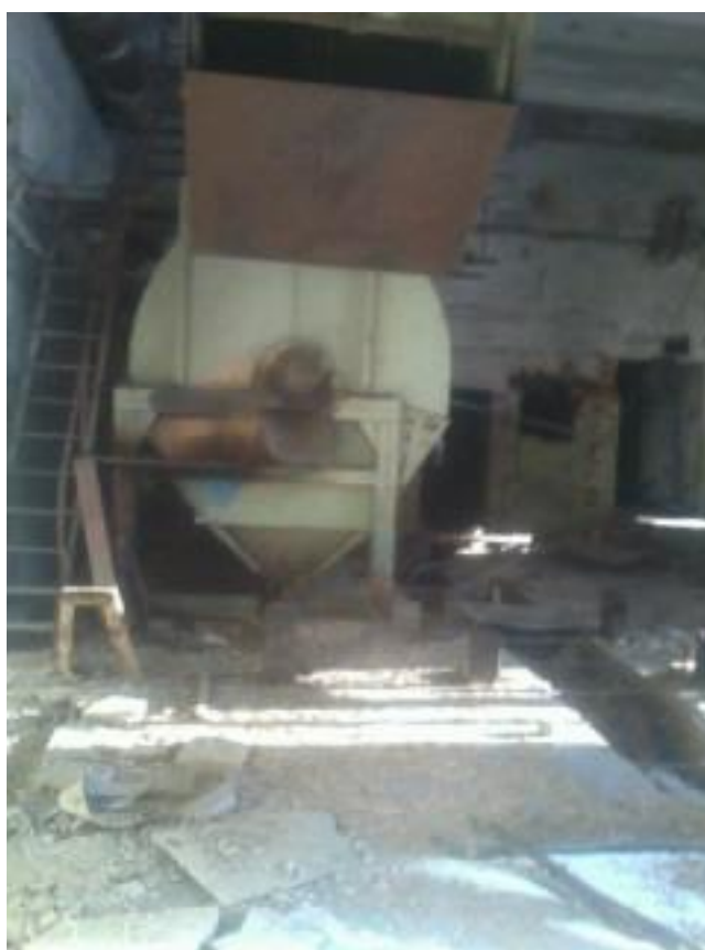
Металлическая ёмкость (бункер, расположенный внутри здания химического цеха, б/у)
