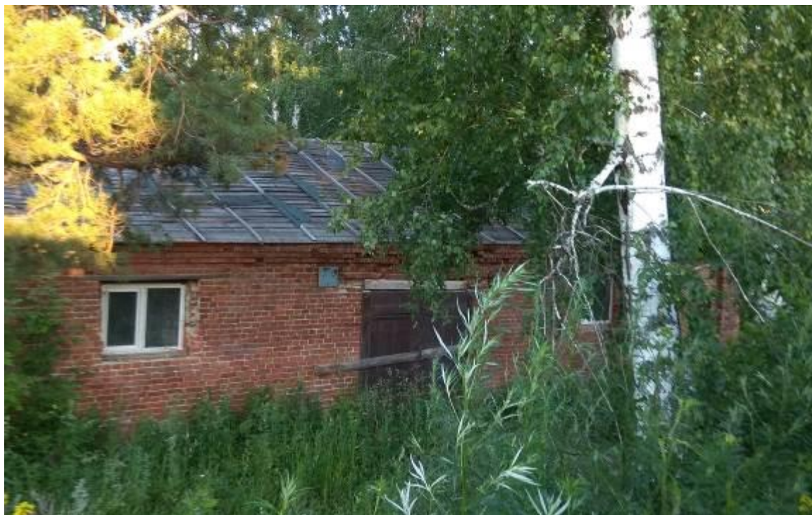
Каменное одноэтажное нежилое здание (кирпич), Инв. № 32_10
