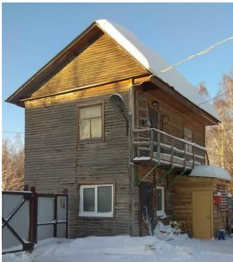
Деревянное 2-х этажное нежилое здание Инв. № 32_7
