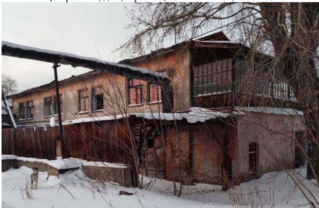
Нежилое здание столярной мастерской общей площадью 431,00 кв. м. г. Томск, ул. Центральная, д. 15, стр., 1
