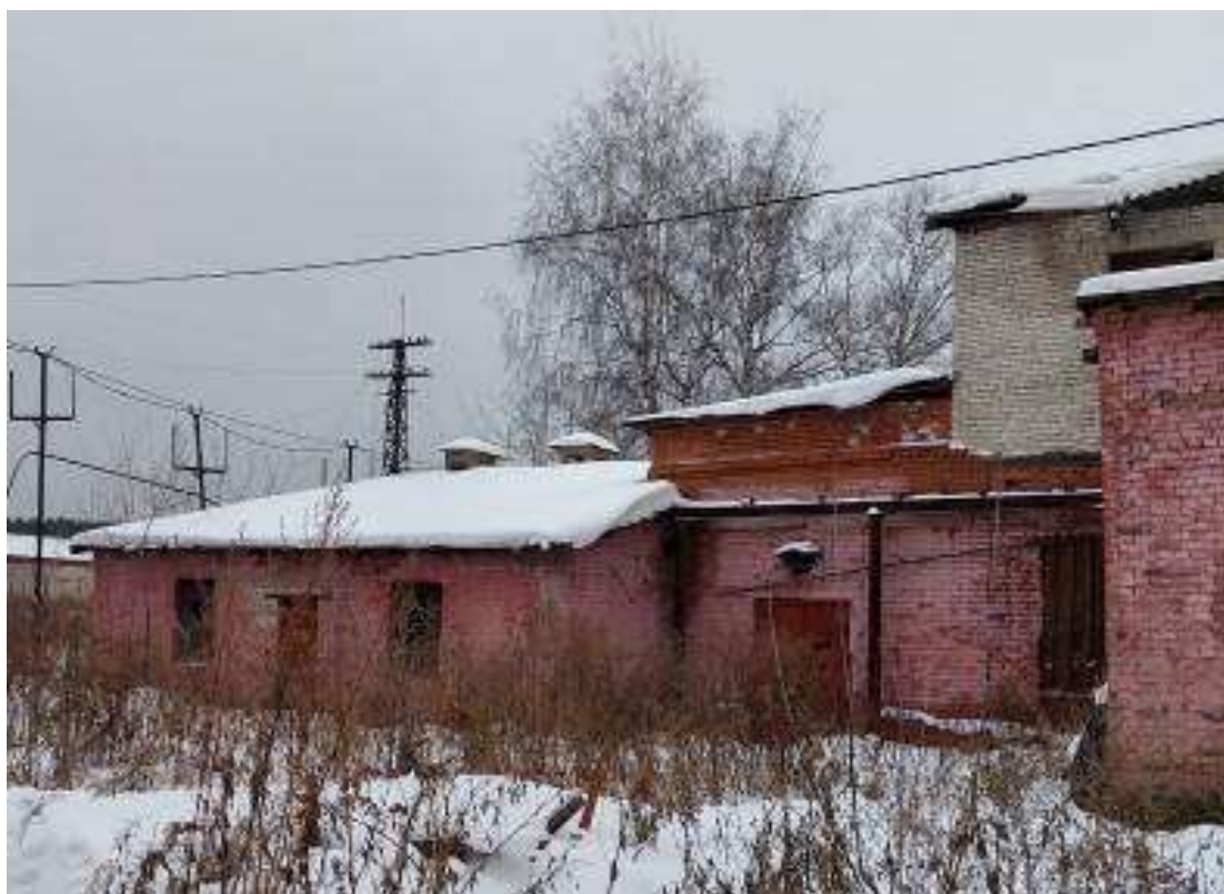
Нежилое здание трансформаторной подстанции общей площадью 121,80 кв.м. г. Томск, ул. Центральная, д. 15, стр. 7
