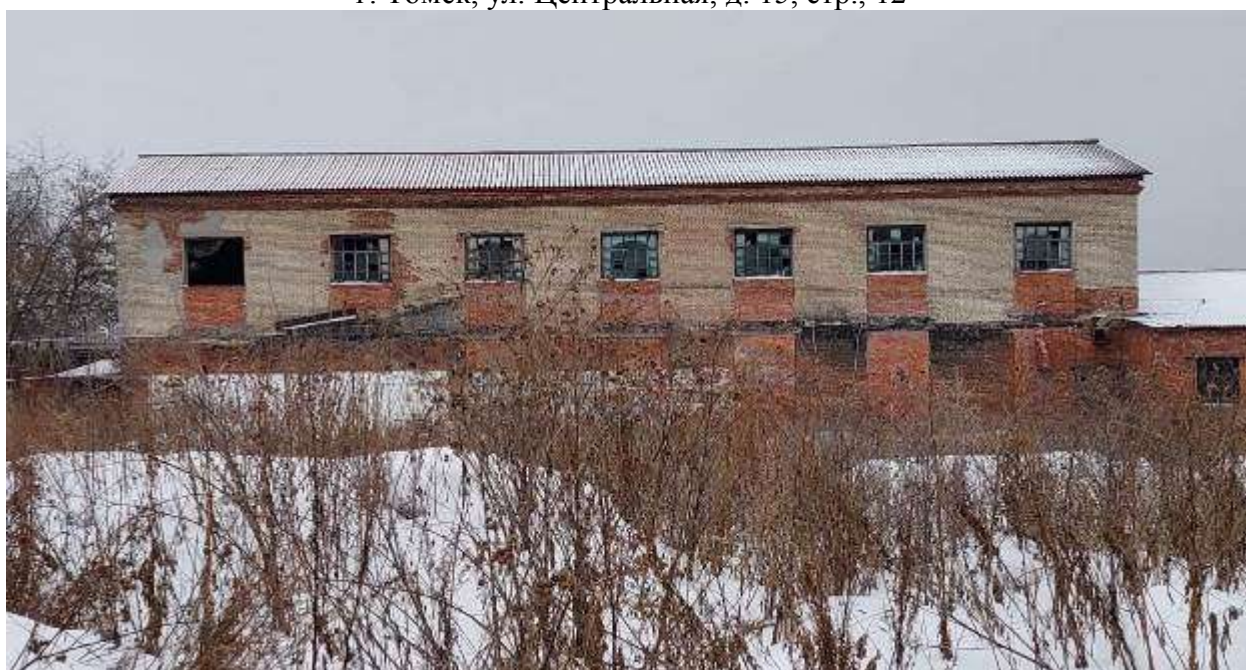
Нежилое здание пропарочной общей площадью 585,10 кв.м. г. Томск, ул. Центральная, д. 15, стр. 11
