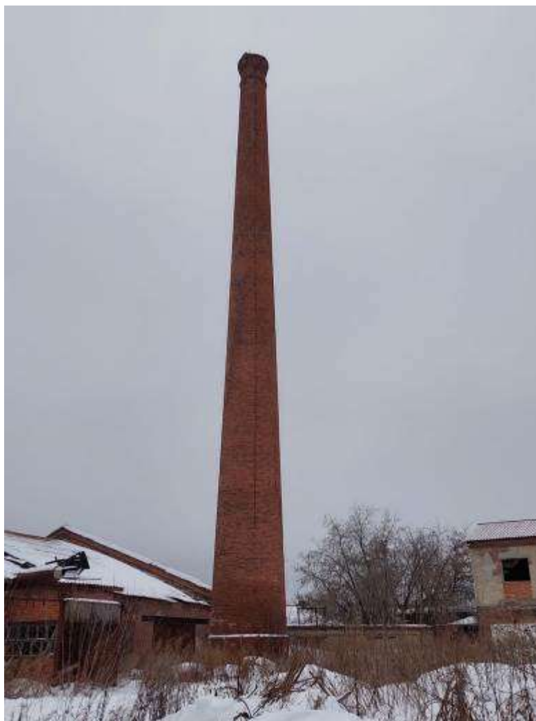
Сооружение - дымовая труба, h=43\text{m} г. Томск, ул. Центральная, д. 15, стр. 8
