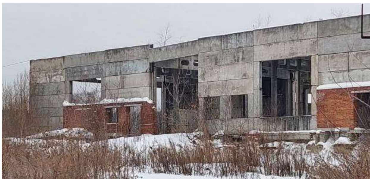
Незавершенное строительство производственного корпуса (площадь застройки 3 804 кв.м.) - г. Томск, ул. Центральная, д. 15, стр. 18
