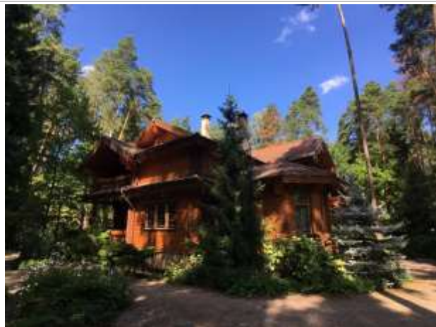
Фотография 3: Фасад дома
