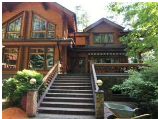
Фотография 1: Фасад дома
