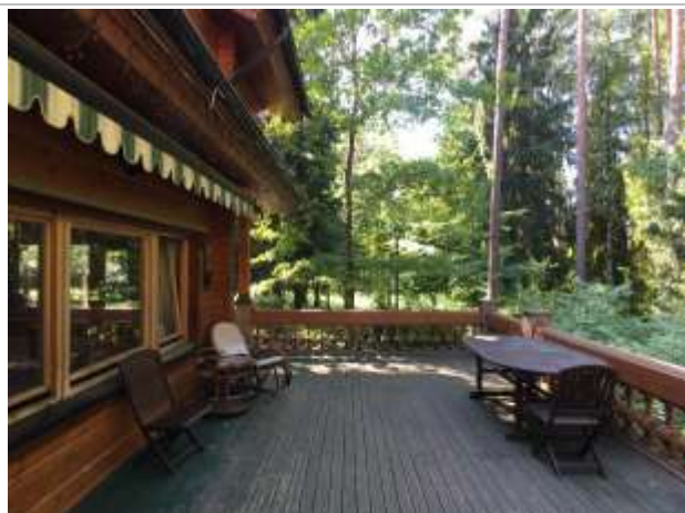
Фотография 5: Фасад дома
