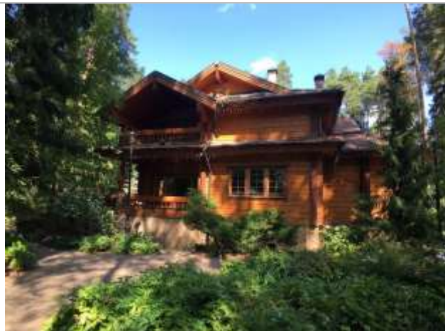
Фотография 2: Фасад дома
