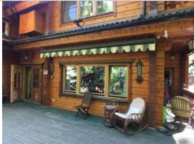
Фотография 4: Фасад дома
