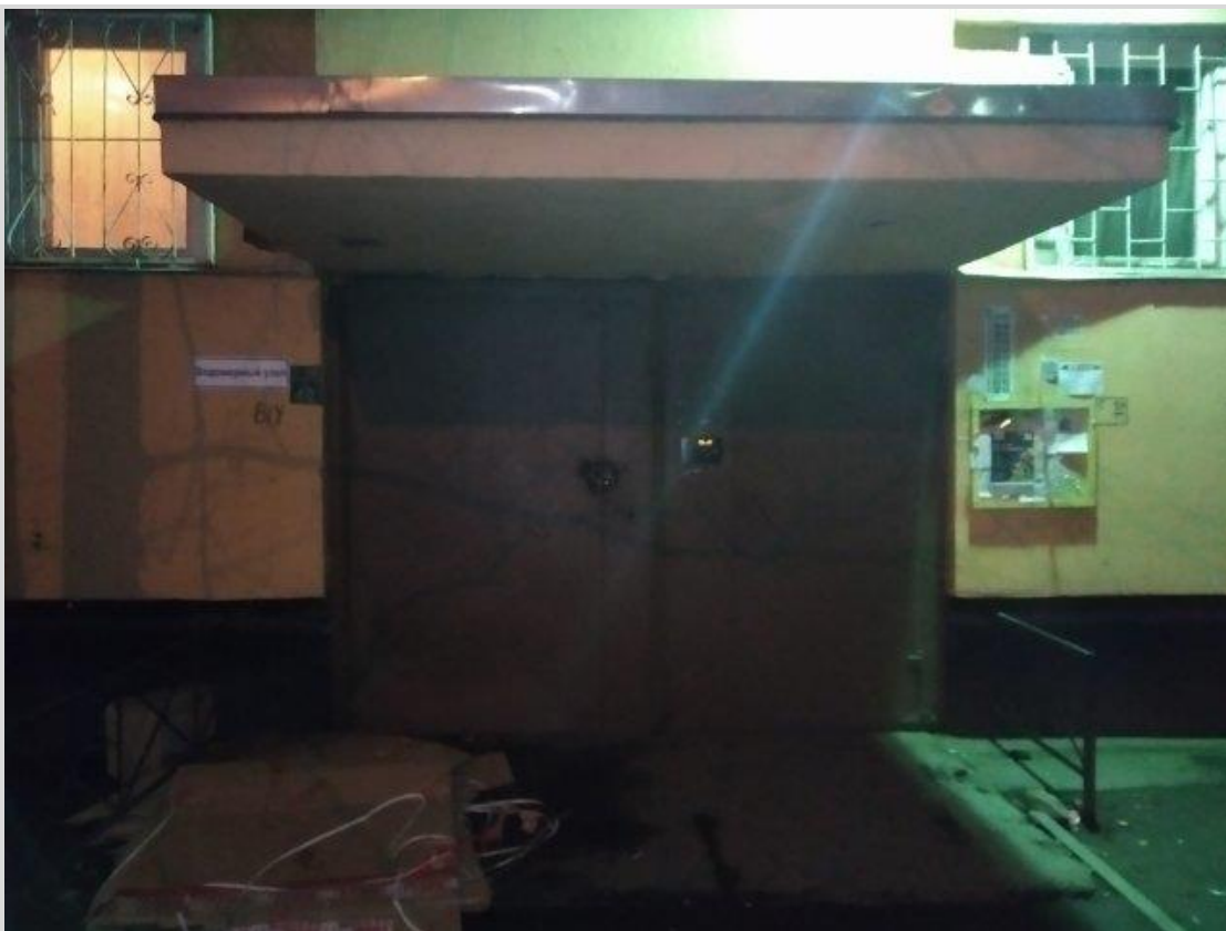
Фото 5. Дверь в подъезд
