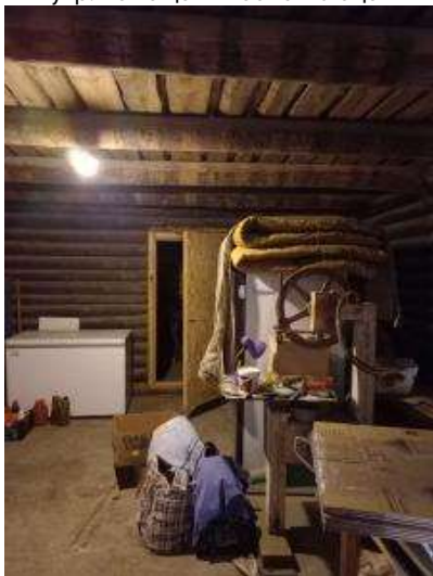
Внутр. помещения объекта оценки
