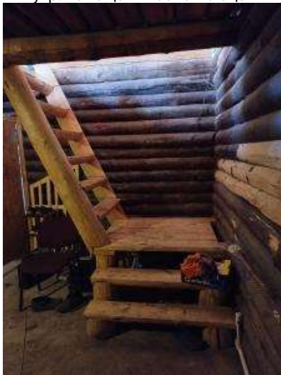
Внутр. помещения объекта оценки
