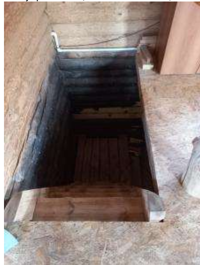
Внутр. помещения объекта оценки
