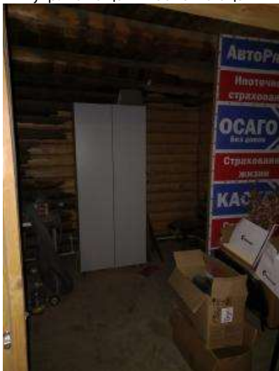
Внутр. помещения объекта оценки
