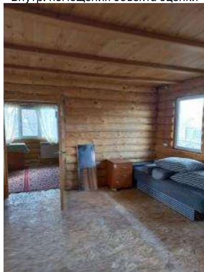
Внутр. помещения объекта оценки
