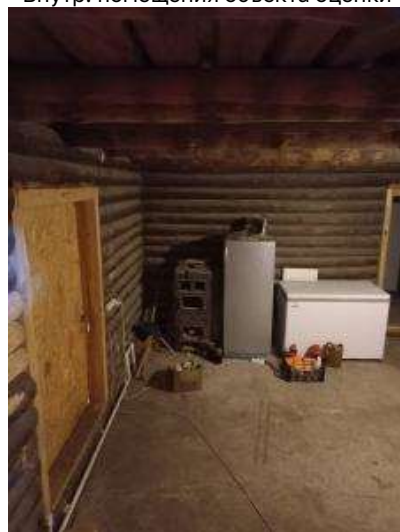
Внутр. помещения объекта оценки
