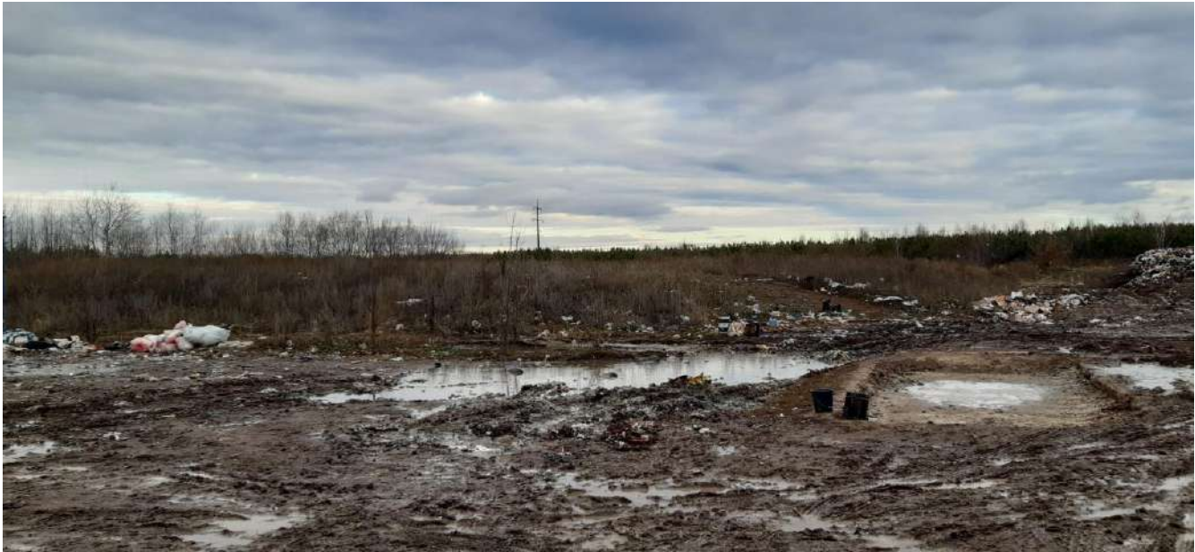
Вид на полигон 1 очередь
