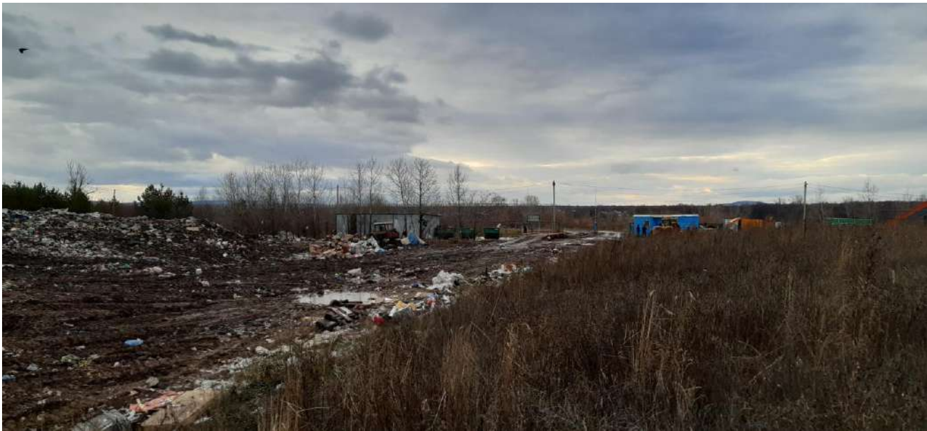
Территория «надвига» на 2 очереди полигона ТКО
