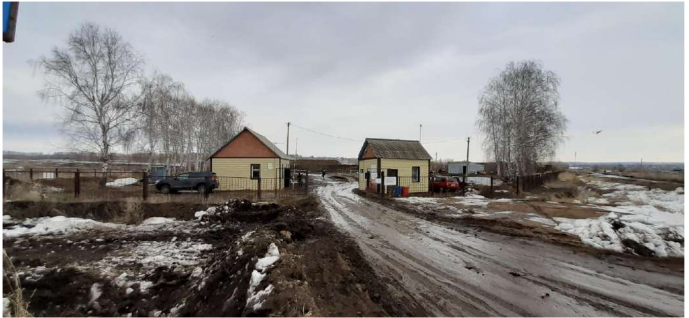
Въезд на территорию полигона ТБО
