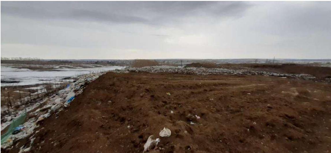
Вид на северо-восточную часть полигона
