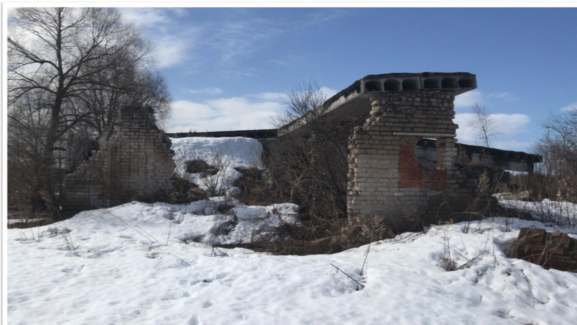
Фотографии объекта №11. Здание скотного двора №6 на 600 голов (1640,88 кв.м.)
