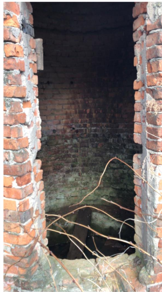
Фотографии объекта №13. Сооружение нежилое, пл.12,6 кв.м. водонапорная башня с артезианской скважиной глубиной 55 м
