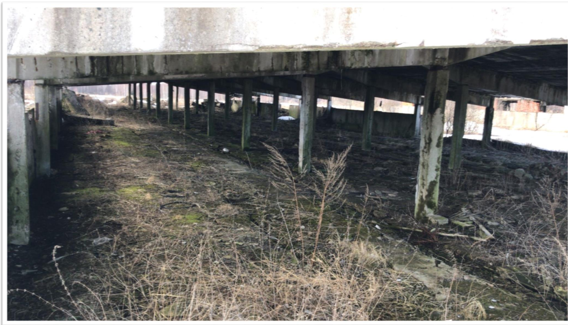
Фотографии объекта №6. Здание скотного двора №3 на 600 голов (1625,40 кв.м.)
