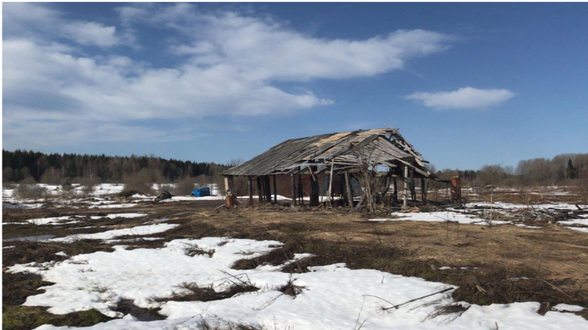
Фотографии объекта №3. Здание склада для строительных материалов (291,90 кв.м.)
