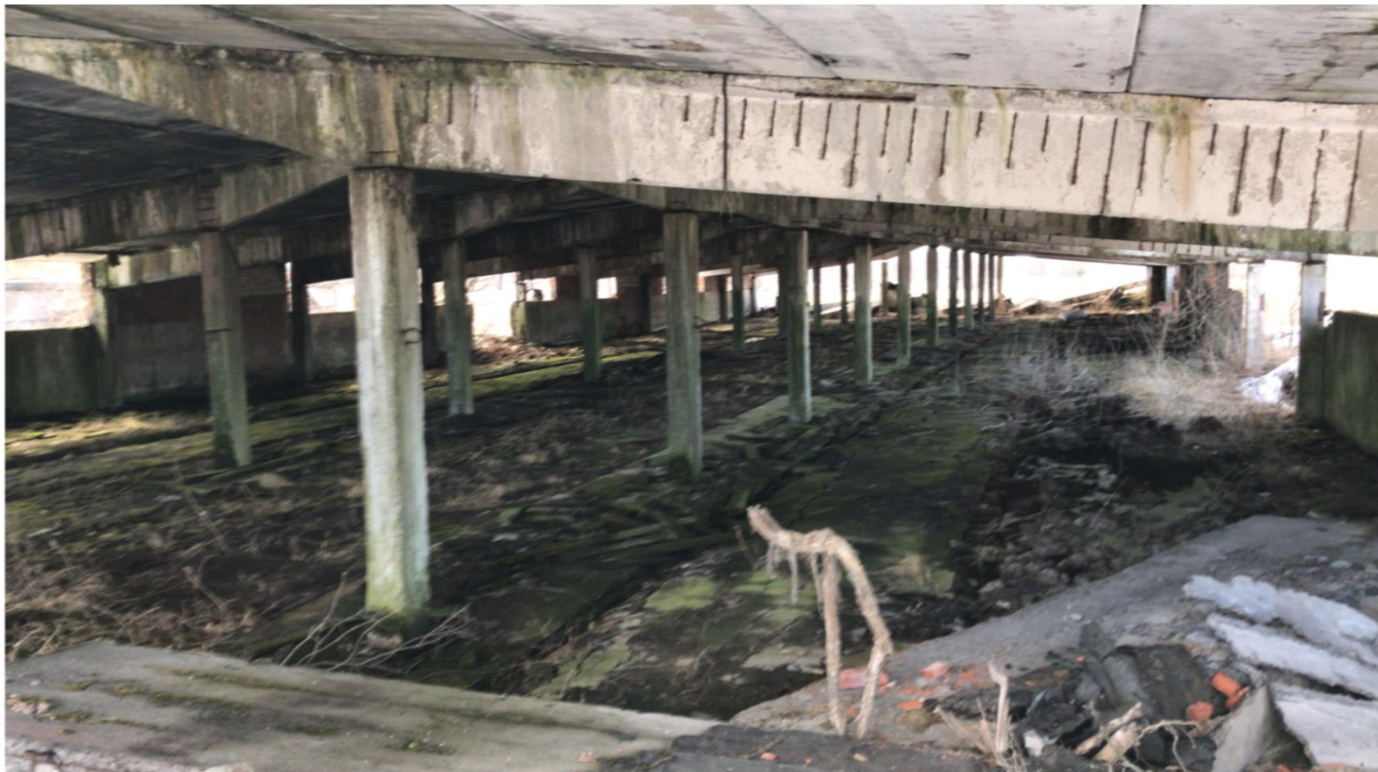
Фотографии объекта №12. Здание скотного двора №2 на 600 голов (1625,40 кв.м.)
