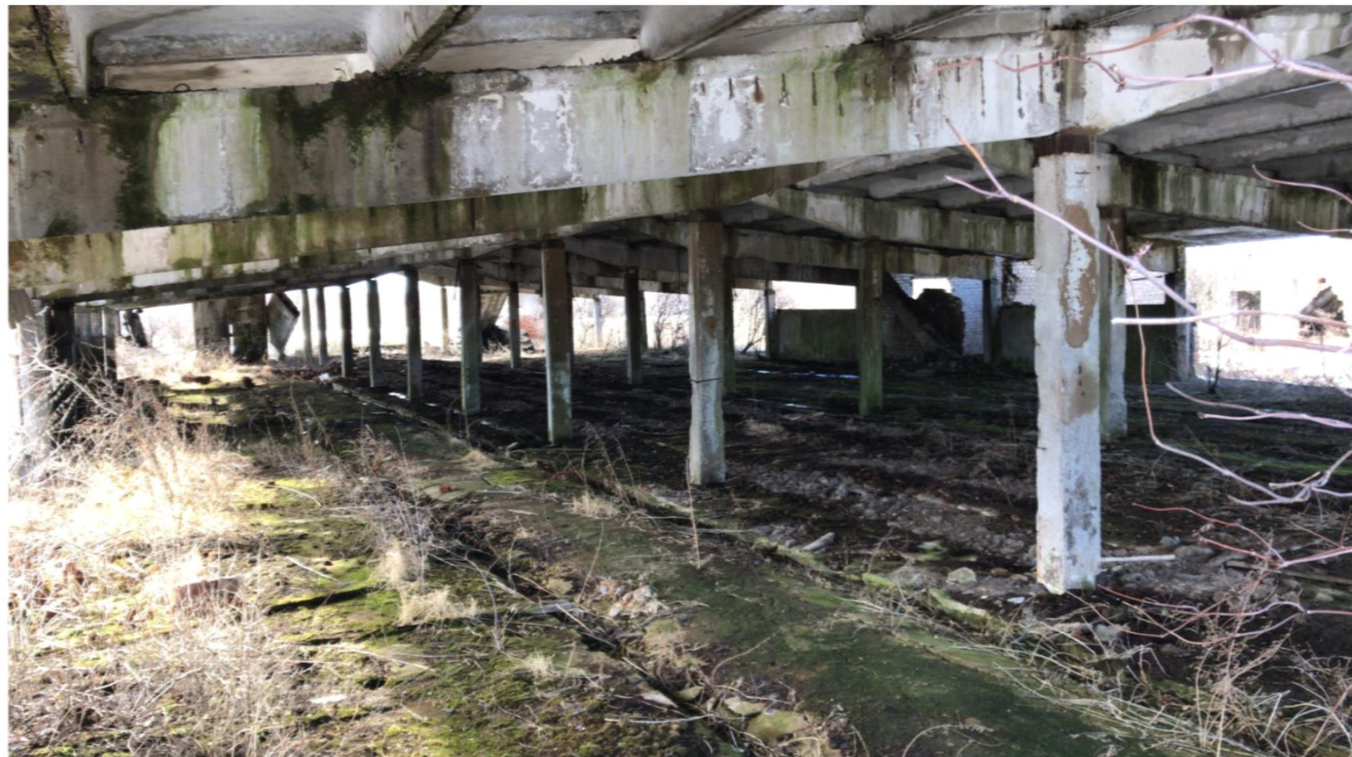
Фотографии объекта №7. Здание скотного двора №4 на 600 голов (1621,80 кв.м.)
