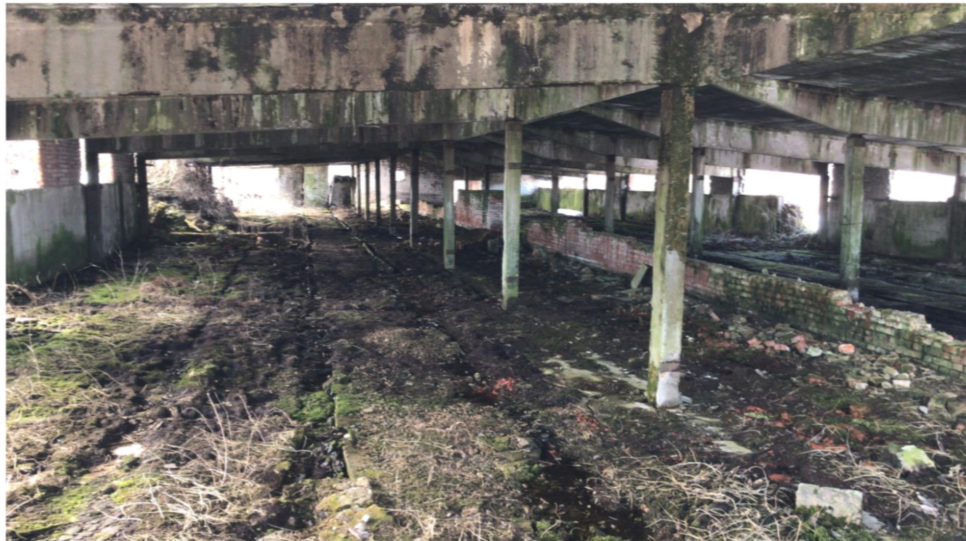
Фотографии объекта №8. Здание скотного двора №5 на 600 голов (1637,01 кв.м.)
