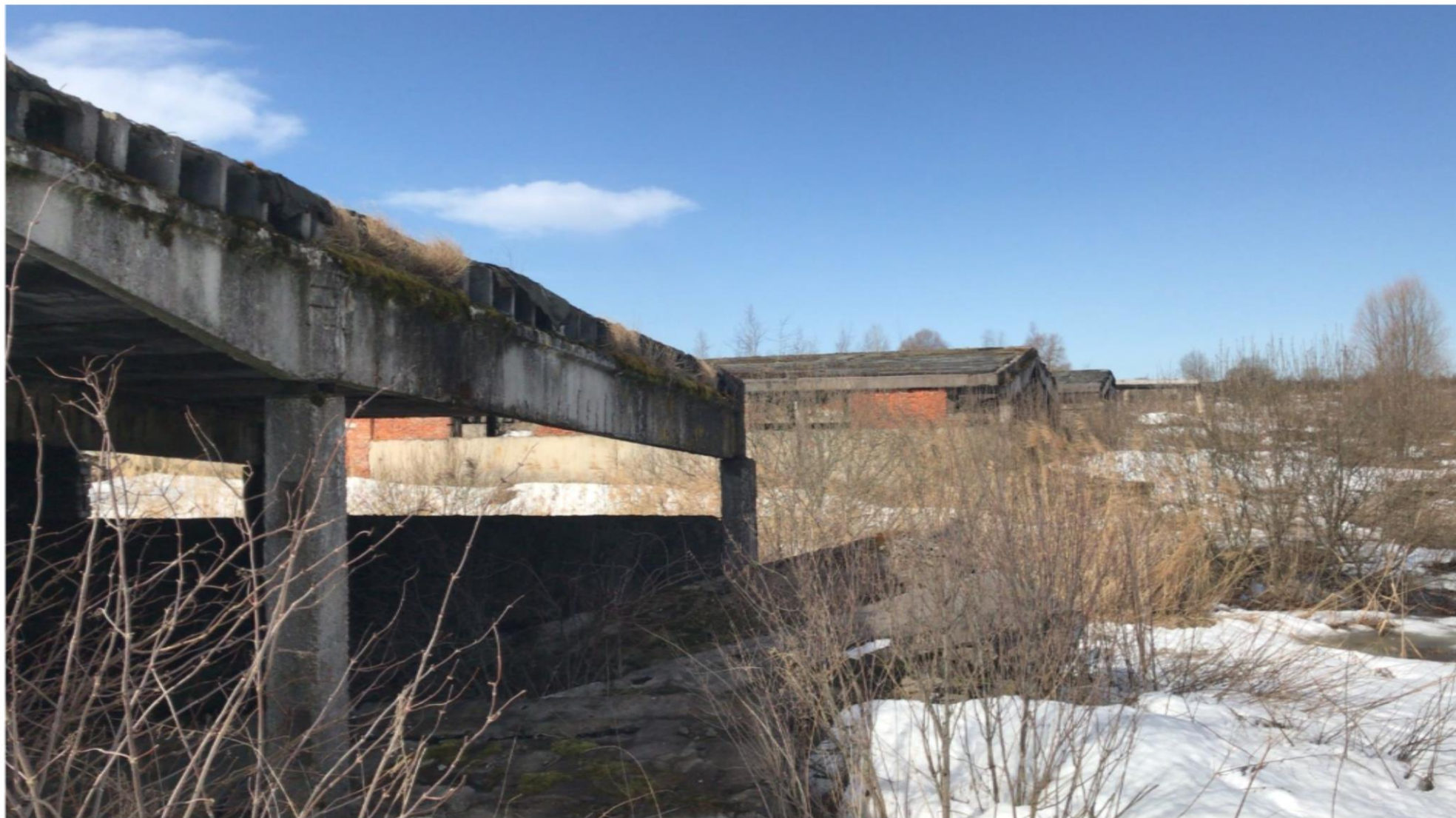
Фотографии объекта №5. Здание скотного двора №1 на 600 голов, (1621,84 кв.м.)
