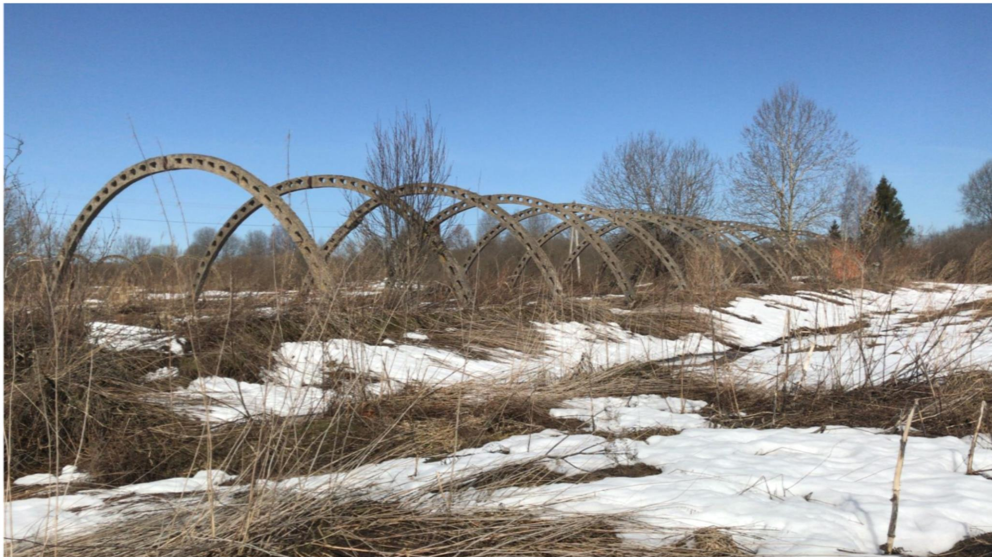
Фотографии объекта №10. Здание арочного скотного двора на 200 голов (504,40 кв.м.)
