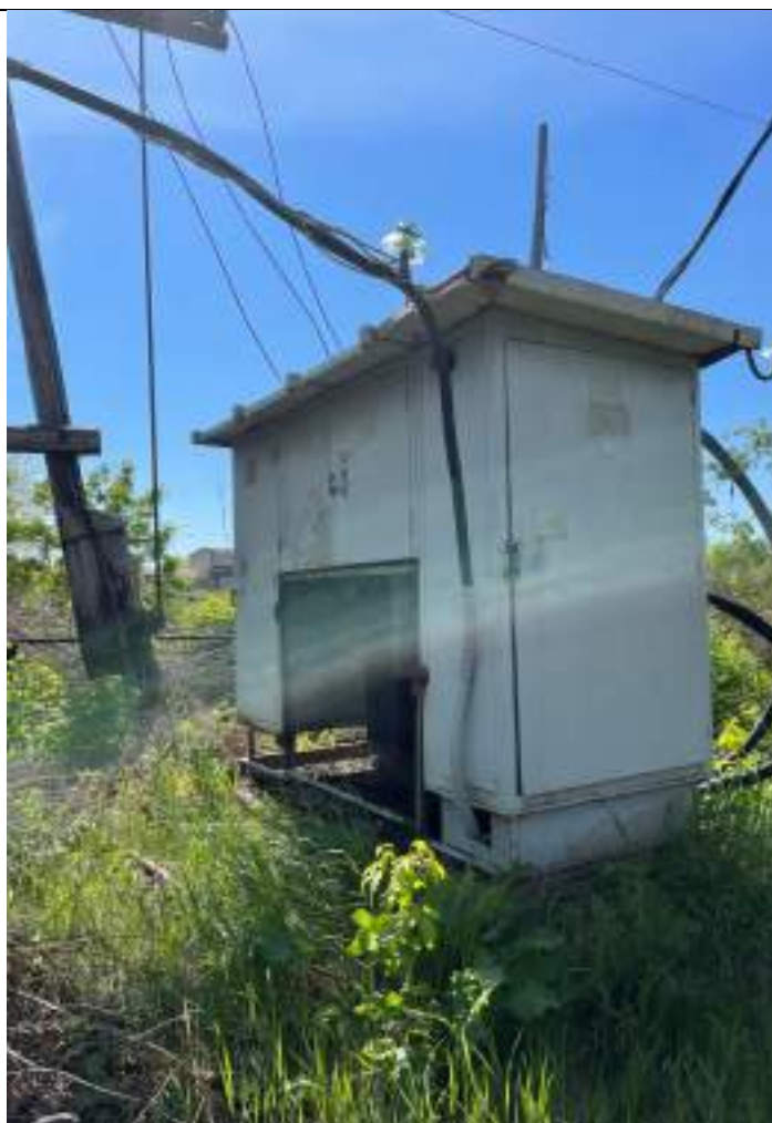
Фото6 Трансформаторная подстанция
